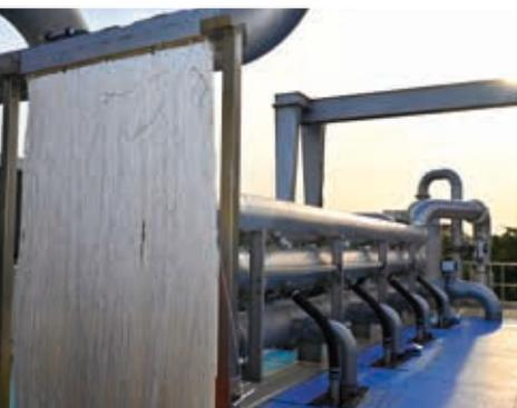
La station d'épuration *Aquaviva* est capable de purifier l'eau usée (les eaux des égouts) grâce à une technologie de filtration membranaire et d'ultraviolets.
